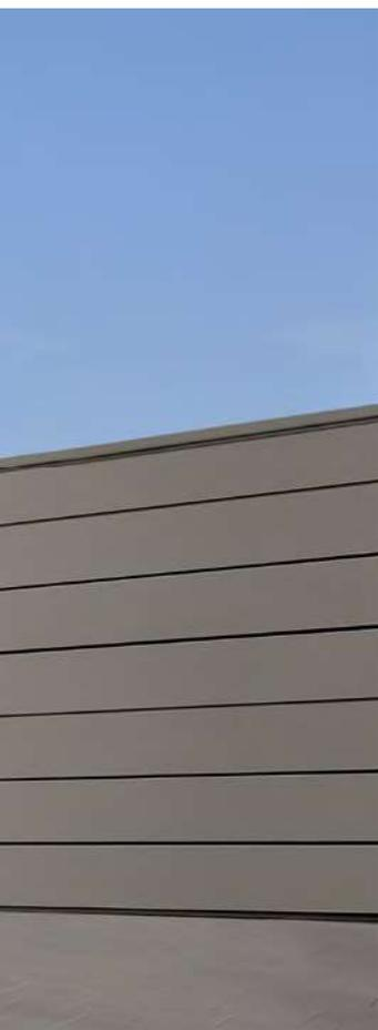
OBEN RECHTS. ALR F42 mit bauseitiger, flächenbündiger Beplankung aus Schichtpressplatten
